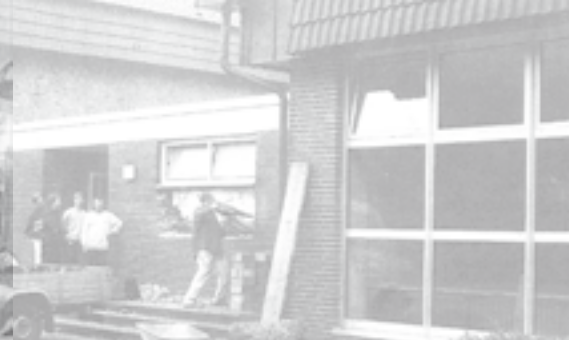
Noch haben die Handwerker einiges zu tun, um die Lehrschwimmhalle in eine Büchereifunktionsräume. Die Schüler verfolgen die Arbeiten mit. Foto: Maria R...
